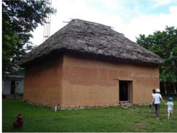
Nhà đất trình tường (kiểu nhà phòng thủ) của người Hà Nhì ở Bát Xát (Lào Cai)
